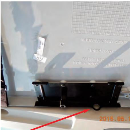
Hier unter der Tischplatte wird der Verschlussknopf eingebaut
