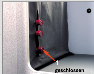
Hauptabsperrrventil
