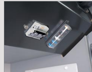
Fehlerstromschutzschalter und Sicherungen
