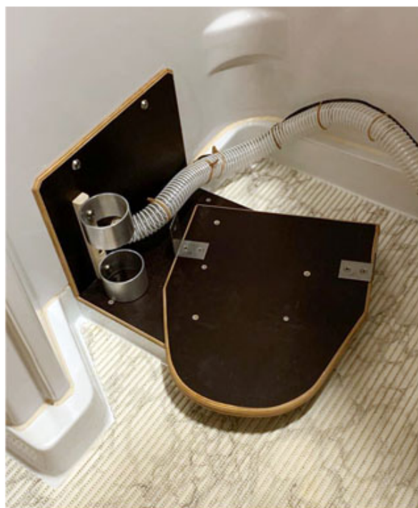
Die alte Toilette ausbauen und den Sockel richten.
