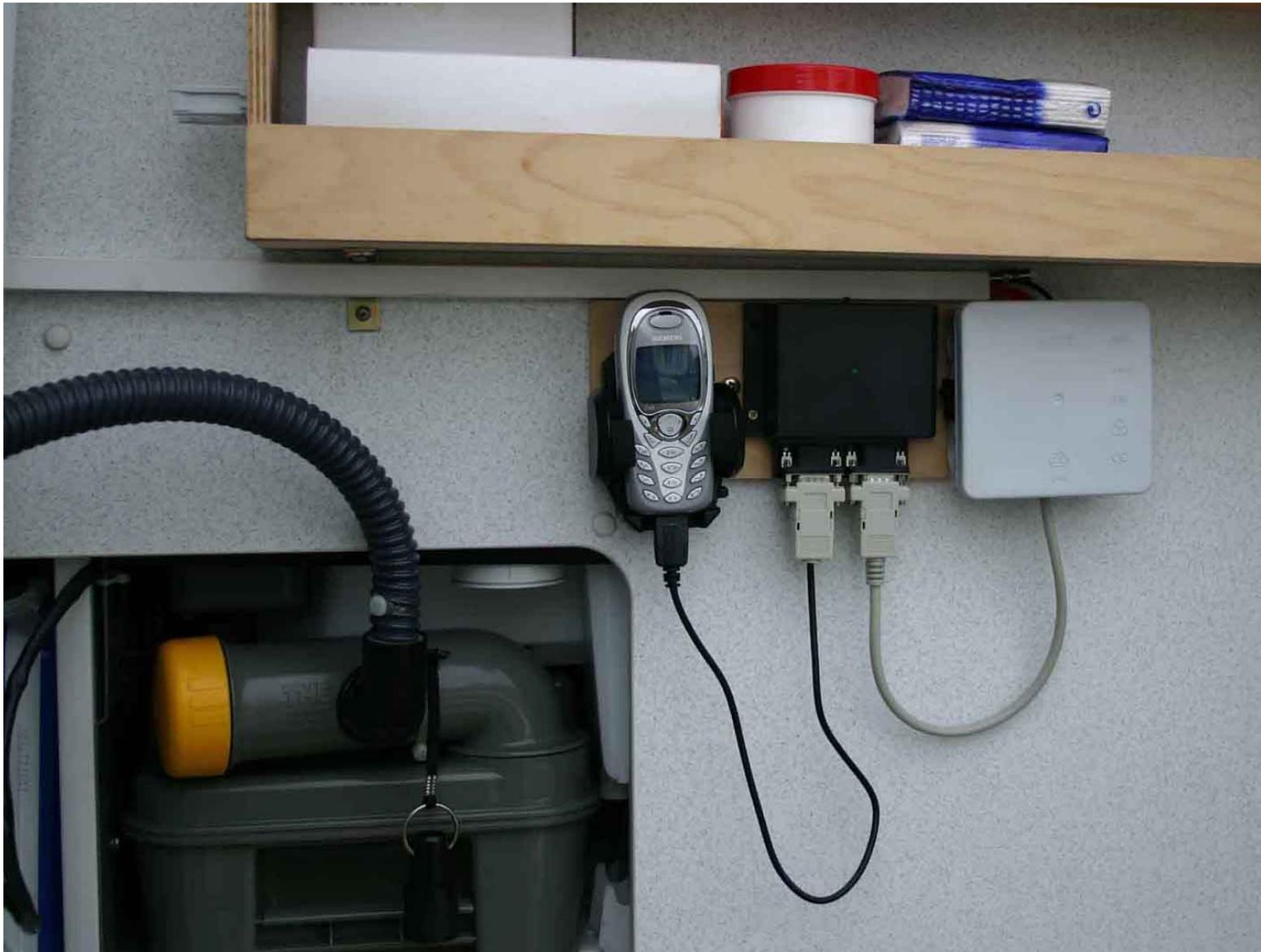
Die Elektrofüchse werden sicherlich erkennen, das man das Relais A 7 weglassen kann, das ist soweit richtig, allerdings fließt dann auch immer ein Strom von etwa 40 mA in das Steuergerät vom Zuheizer, ja und Kleinvieh macht auch Mist, jeder muss das selber wissen.
