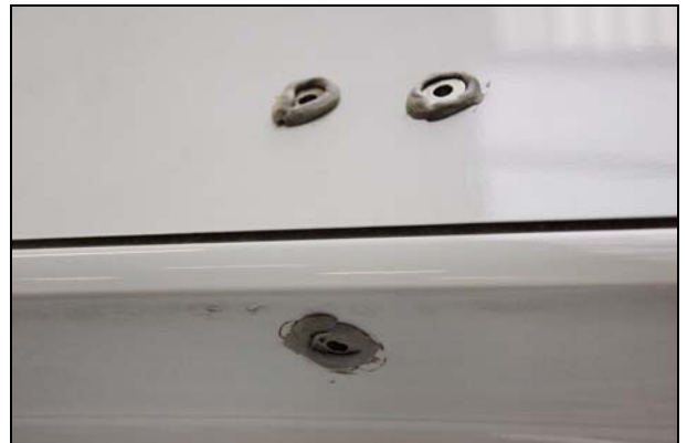
Abb.: Schraubensäfte mit Dichtbandring versehen
