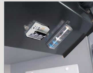
Fehlerstromschutzschalter und Sicherungen
