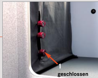
Hauptabsperrrventil
