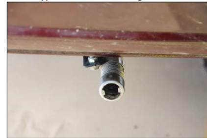
Abb.: knapp über die Außenkante ragendes Ende
